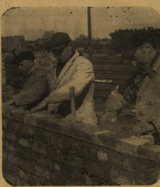
Восстановительные работы в Рижском порту.
