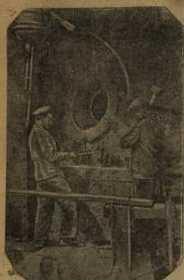
В освобожденном Донбассе. Ремонт доменной печи на Енакиевском металлургическом заводе.
