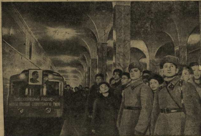
На снимке: станция московского метро.
