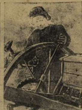
Колхозники сельхозартели имени Л. М. Кагановича (Свободненский район, Амурская область) хорошо готовятся к севу. В колхозе закончен ремонт борон, плугов и другого инвентаря. На снимке: кузнец А. К. Песоцкий ремонтирует сеялку.
