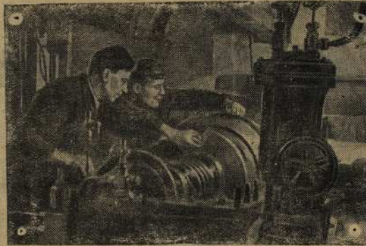
За необычайно короткий срок—17 дней—заключен монтаж мощной турбины теплоэлектростанции Кузнецкого металлургического завода имени Сталина. На снимке: проверка переднего подшипника турбины после первого пуска.
